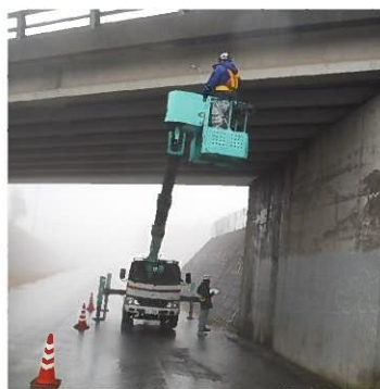
高所作業車による近接目視
