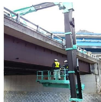
橋梁点検車による近接目視
